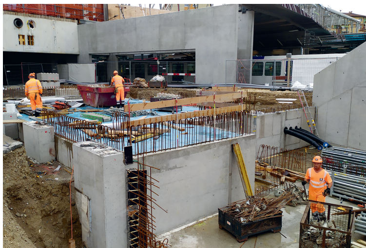
Au sud de la gare, les radiers de la tête sud sont terminés, et les premiers murs du futur accès à la passerelle ont été bétonnés
